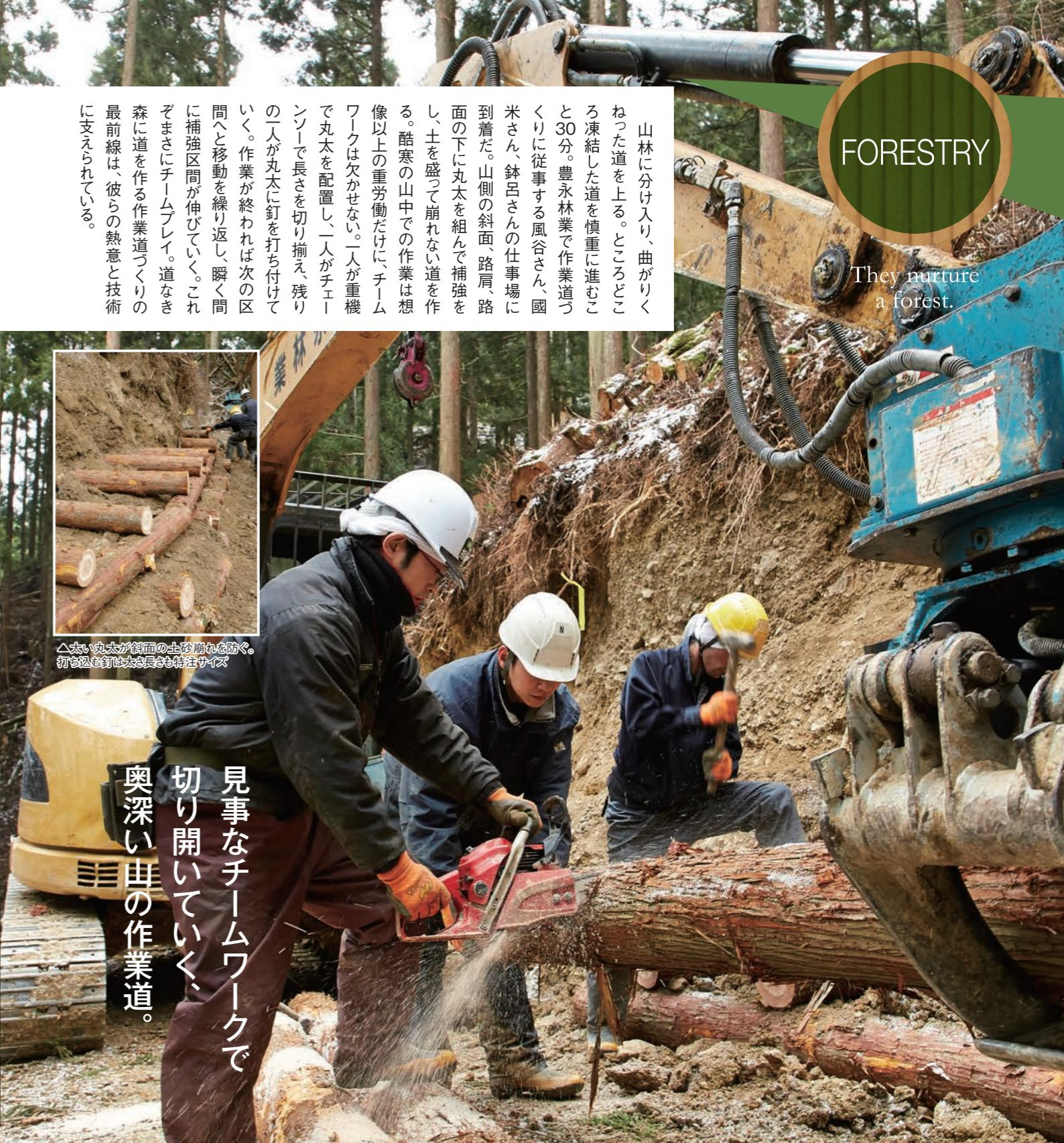
山林に分け入り、曲がりくねった道を上る。ところどころ凍結した道を慎重に進むことを30分。豊永林業で作業道づくりに従事する風谷さん、國不さん、鉢呂さんの仕事場に到着だ。山側の斜面、路肩、路面の下に丸太を組んで補強をし、土を盛つて崩れない道を作り。酷寒の中での作業は想像以上の重労働だけに、チームワークは欠かせない。一人が重機で丸太を配置し、一人がチエーンソーで長さを切り揃え、残り一人が丸太に釘を打ち付けていく。作業が終われば次の区間へと移動を繰り返し、瞬く間に補強区間が伸びていく。これまさにチームプレイ。道なき林に道を作る作業道づくりの最前線は、彼らの熱意と技術支えられている。
